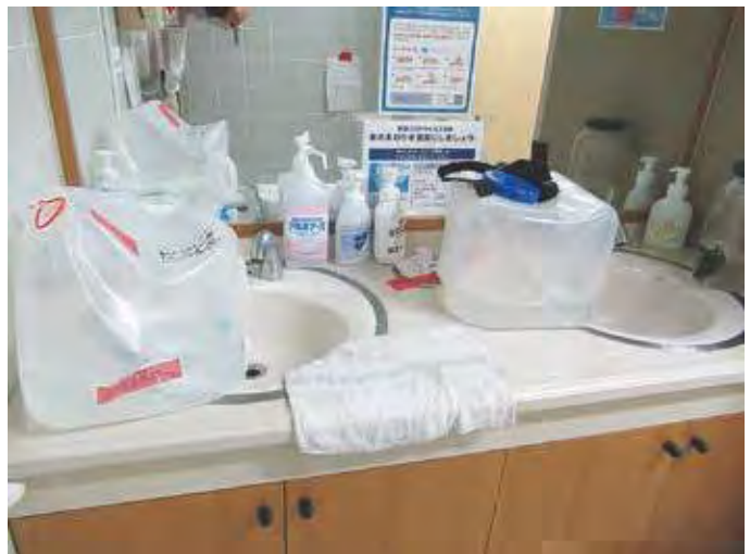
同時期の同施設内のトイレの手洗い場。 断水のため、ウォータータンクを横にして手洗い用としている。
